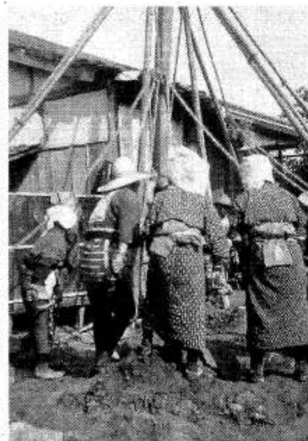
①土台の基礎固め ②渡部家の家屋建築の様子、1930年6月20日 ③いずれも若松秀俊教授提供
