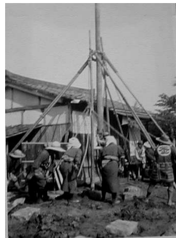
Ein Nachbar arbeitet öffentlich mit Arbeitsgesang Beim Bauwerk des neuen Hauses Watanabe
