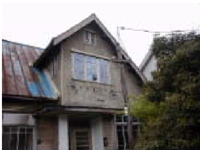
カルシシュ一家の住んだ松江市奥谷町の官舎
